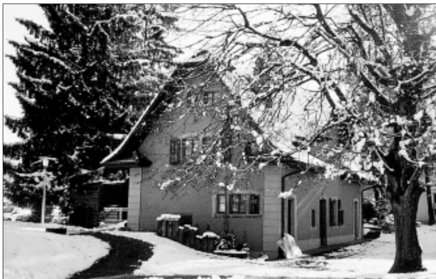
Das ehemalige Wirtschaftsgebäude bei der AndreasKlinik soll umfassend saniert werden.
