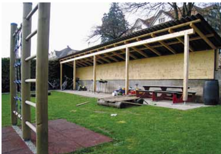
Unterstand der Liegenschaft Rigistrasse 7.
