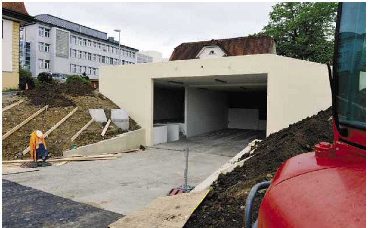
Die neue Anlieferung für die AndreasKlinik / das Pflegezentrum vor der Fertigstellung.
