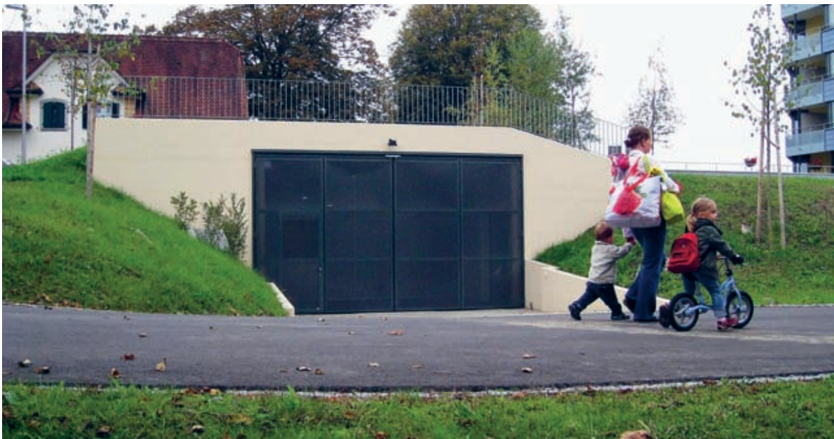
Die neue Anlieferung AndreasKlinik / Pflegezentrum.
