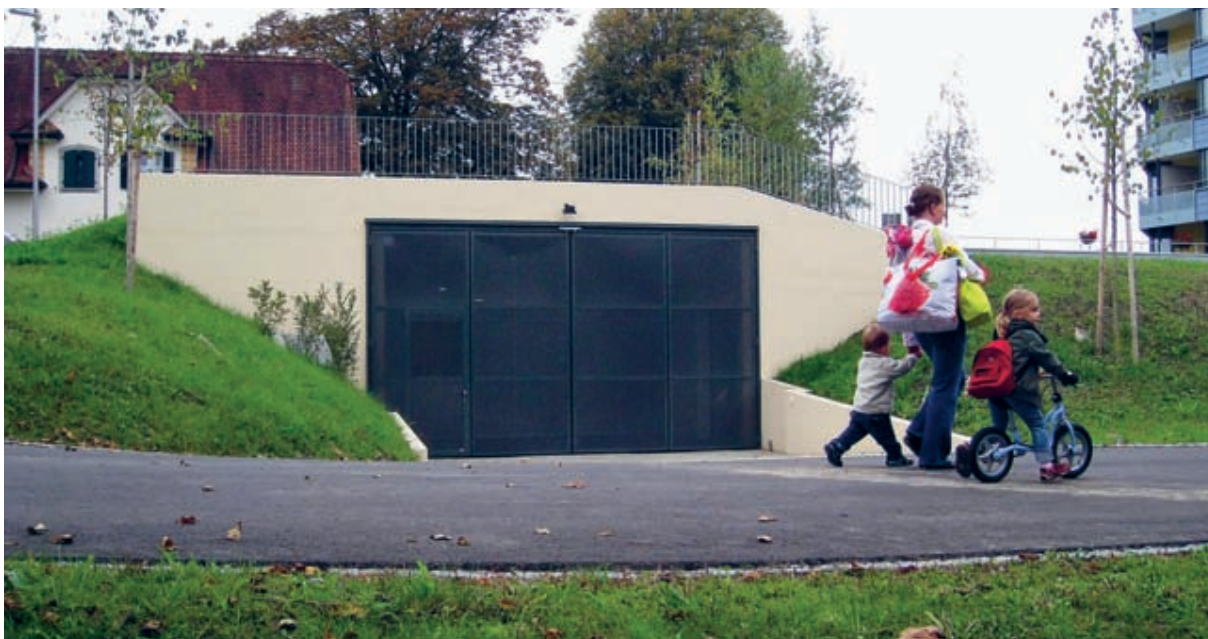
Die neue Anlieferung AndreasKlinik / Pflegezentrum.
