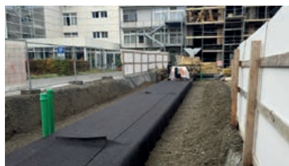
Im Bau: der Verbindungsgang zwischen Pflegezentrum und AndreasKlinik.
