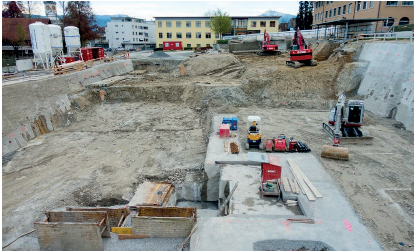
Die mächtige Baugrube wird ausgehoben, Stand 11. April 2016.
