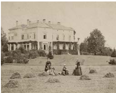
Die Villa Villetta um 1866, kurz nach ihrer Fertigstellung.
