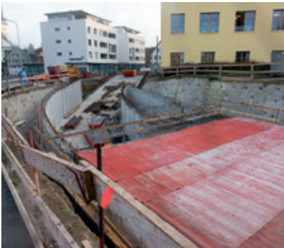
Die Rampe zur Tiefgarage im Bau.
